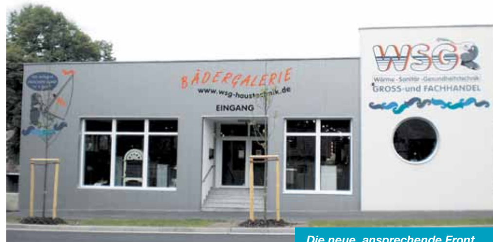
Die neue, ansprechende Front der WSG Bädergalerie ist schon von weitem zu sehen
